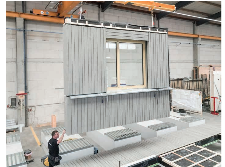
Vorfertigung der Wandelemente.
