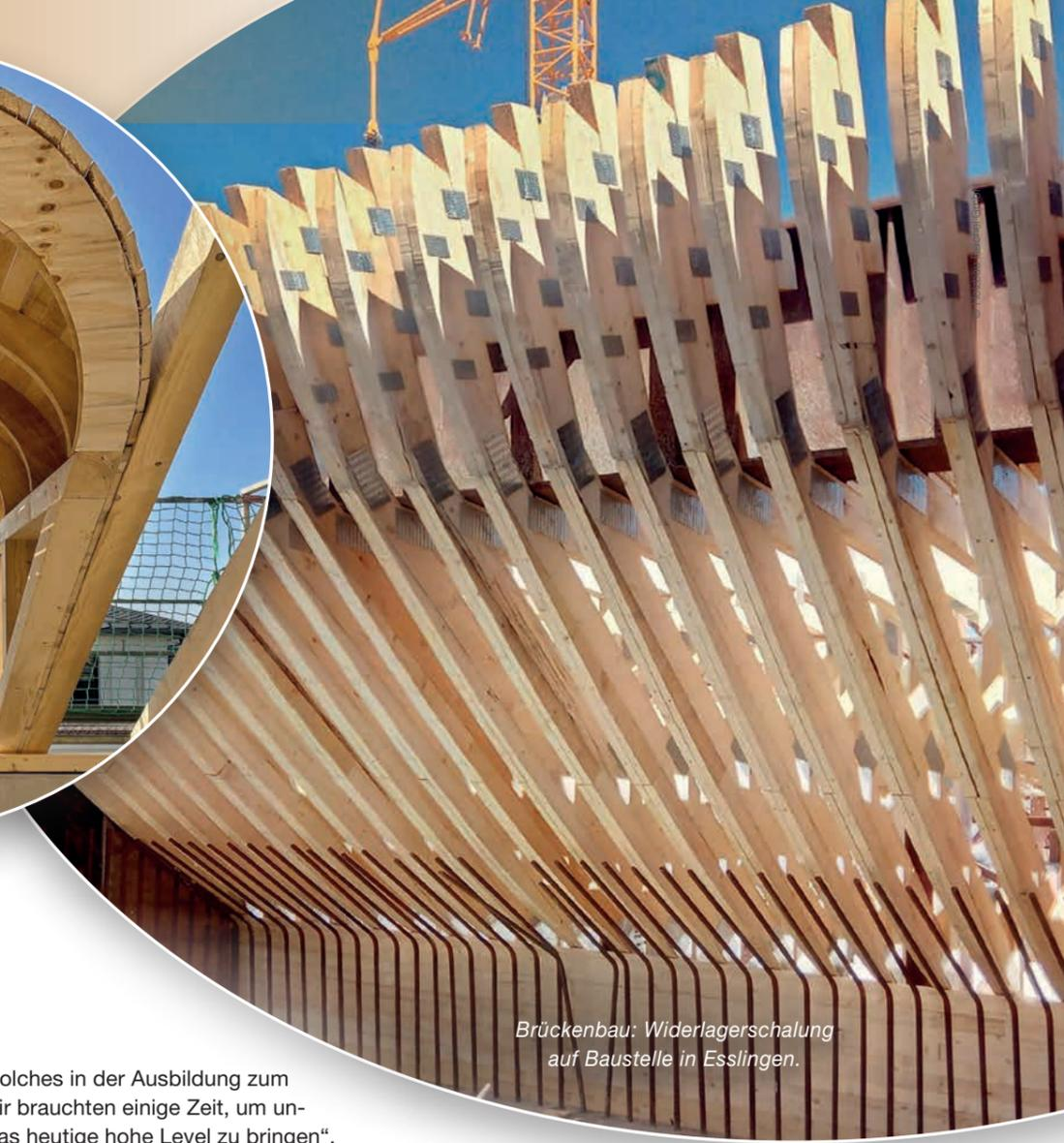
Brückenbau: Widerlagerschalung auf Baustelle in Esslingen.
